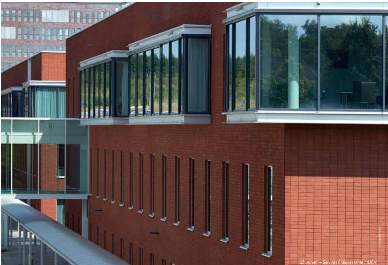
UZ Leuven – Services Critiques (ar-te / d.JGA)
