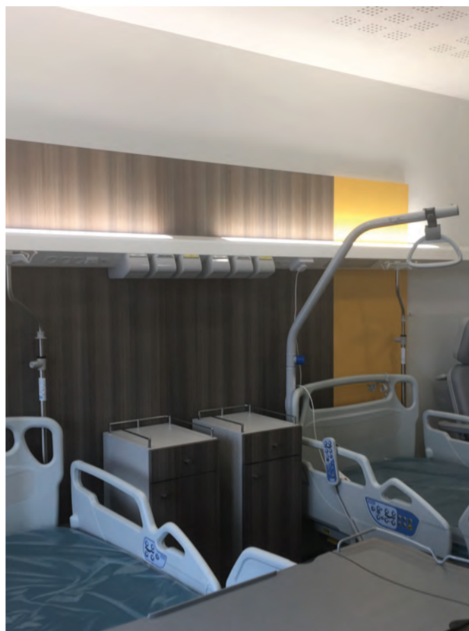
Configuration d'une tête de lit pour chambre double - Centre Hospitalier de STELL
