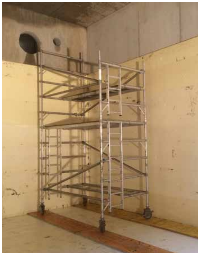
Travaux d'isolation d'une cuve de stockage de glace
