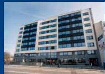
Résidence Gray Couronne 2013 - Bruxelles Construction - ORPEA 102 salles de bain
