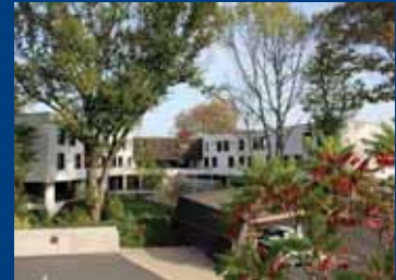
EHPAD du Prissé 2014 - Bayonne Construction - Eiffage 107 salles de bain
