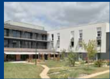
EHPAD Les Tilleuls 2016 - Lion d'Angers Construction neuve - ICADE 71 salles de bain
