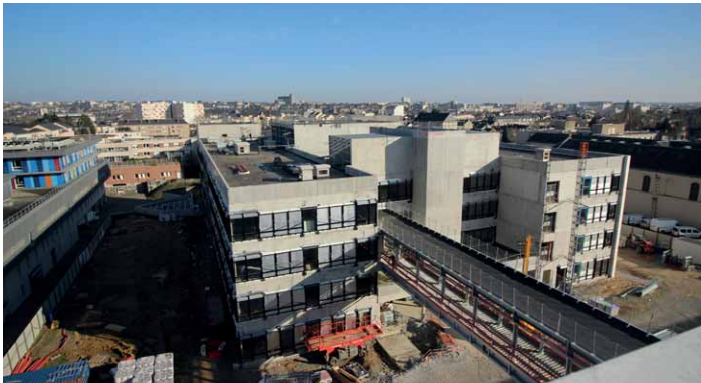
Chantier du futur bâtiment Madeleine Brès - ©Air2D3
